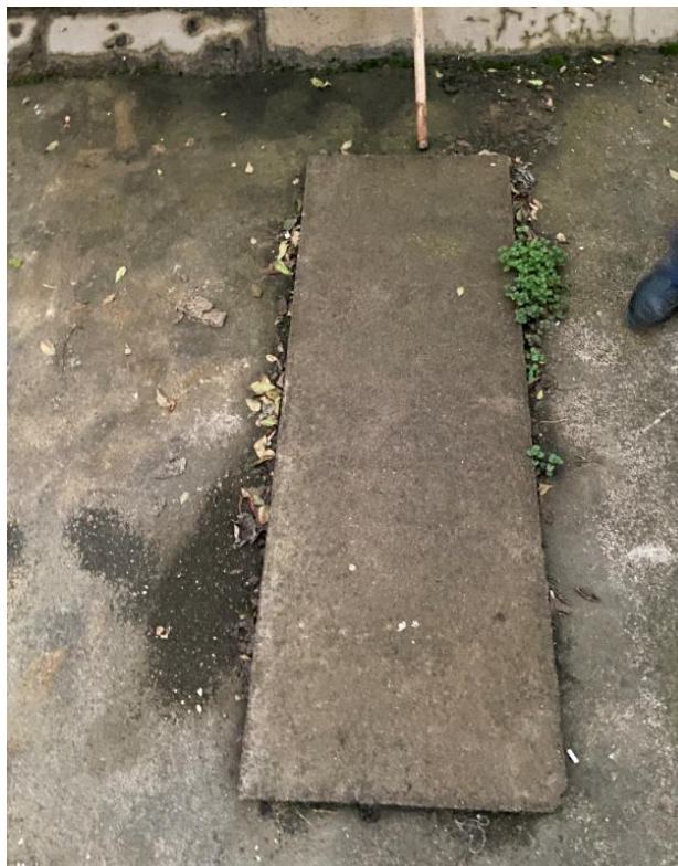
地埋式化粪池
