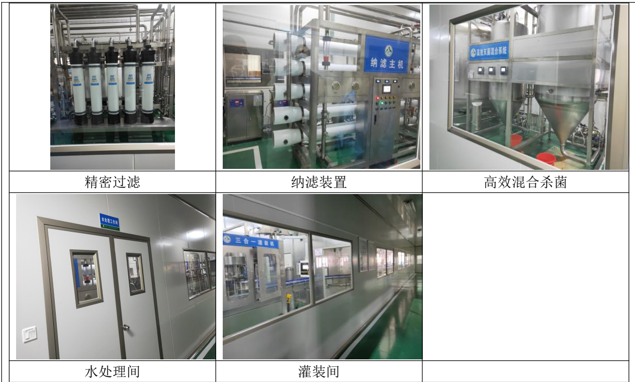
图 2-1 项目现场情况
